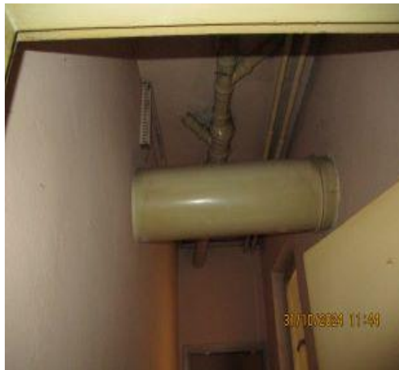
вентилациона цев кроз коју се, преко суседног тоалета, обезбеђује доток свежег ваздуха у просторију за задржавање
